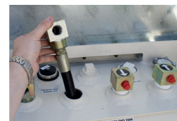
Connexion pour groupe électrogène
