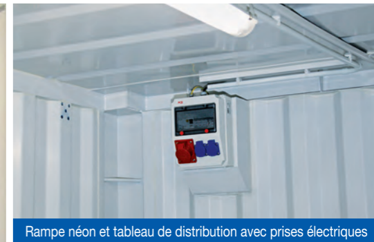
Rampe néon et tableau de distribution avec prises électriques
