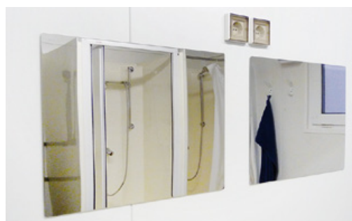
Spiegel van plaatijzer (onbreekbaar)
