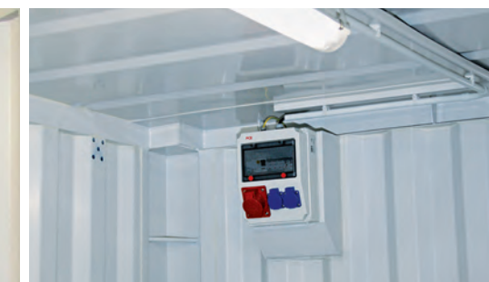
Lichtbalk en verdeelkast met stopcontacten
